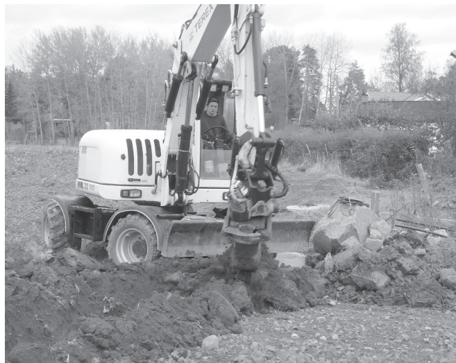
Grävning för fiber i december bakom gamla macken i Jönninge.
